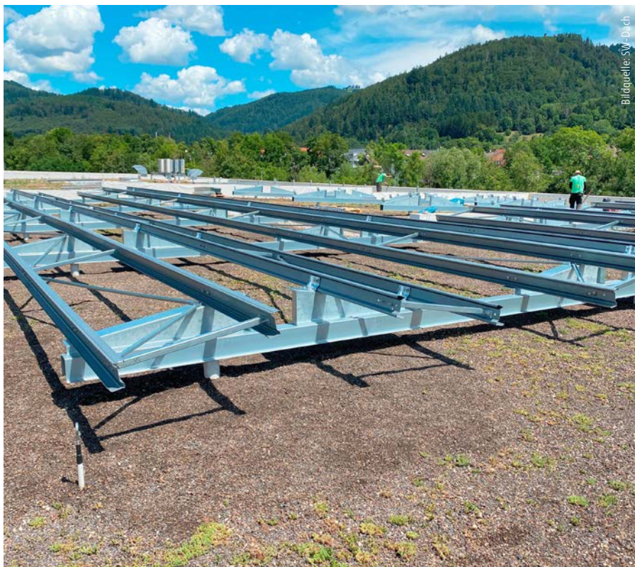
Die Unterkonstruktion Tratec im Aufbau. Hier werden final noch PV-Module montiert mit einer Anlagenleistung von knapp 700 kWp.
